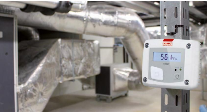
CO2ST instalado en el local de tratamiento del aire de una infraestructura industrial.
